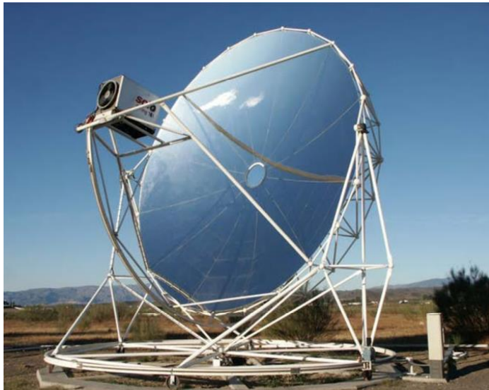
Abbildung 35: Prototyp einer 10kW Dish-Stirling-Anlage bei Almería in Spanien.
