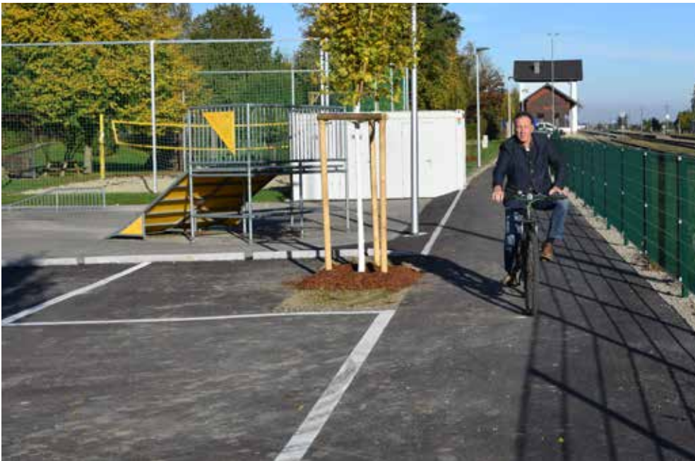
Der neue Verbindungsweg von der Firschaumstraße zum Bahnhof ist fertig. (Foto Gemeinde)
